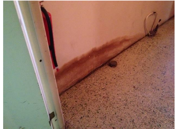
Missfärgning i mellanvägg närmast kontor
