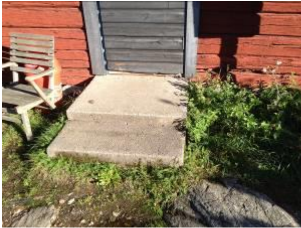
Exempel på betongtrappa som ansluter mot träkonstruktion
