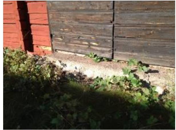
Exempel på betongtrappa som ansluter mot träkonstruktion
