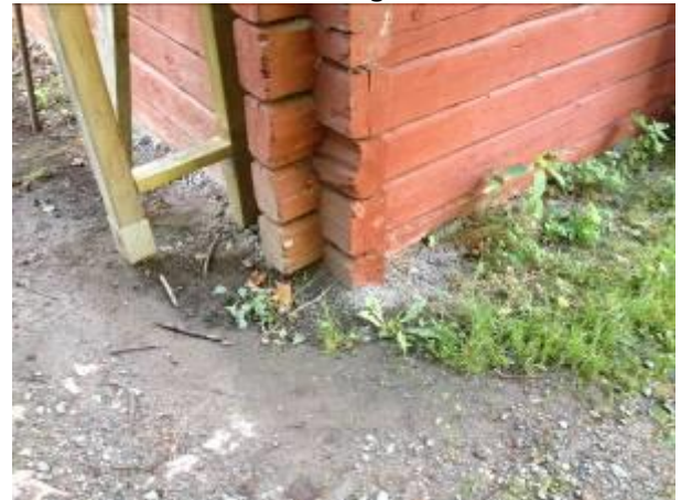
Motfyllda stockar vid byggnadens nordvästra hörn
